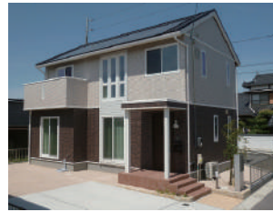
1号地外観(2021年4月撮影)
