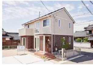
1号地外観(2021年6月撮影)
